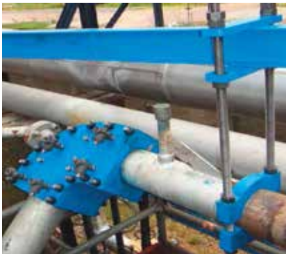
Boite d'assemblage mécano soudée avec support
