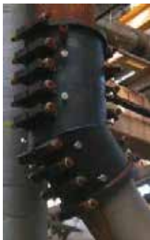
Boite d'assemblage mécano soudée avec support
