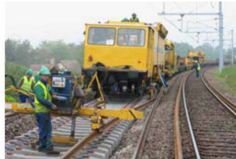
Longs rails soudés sur traverses béton
