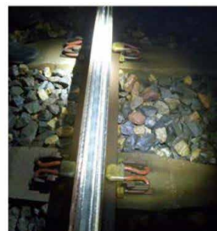
Rail après meulage
