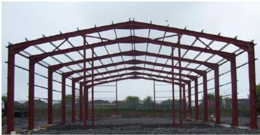
Figure 3 : Portique courant en profilés laminés à chaud
