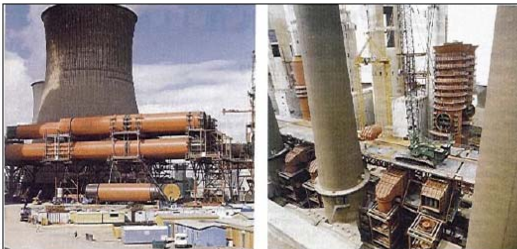
Figure 4.18 : modification de la technologie FGD dans une installation existante [94, Umwelt + Technik, 2000]
