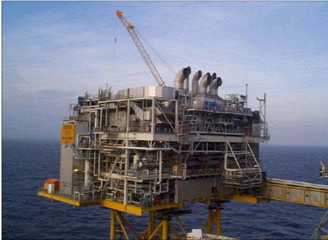
Figure 7.21 : exemple d'une centrale électrique à cycle combiné installée sur une plateforme offshore sur le plateau continental norvégien [25, ABB, 2000]
