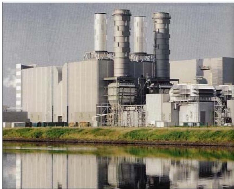
Figure 7.8 : centrale électrique à turbine à gaz à cycle combiné récemment construite en Belgique.
