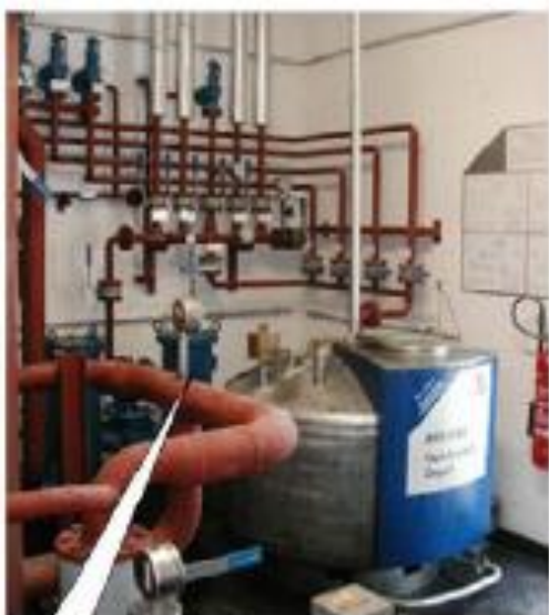
Figure 4.27 : Station de pompage numéro 2 avec filtre et conteneur à déchets pour le nettoyage du filtre [50, Allemagne, 2006], [51, EuLA, 2006]
