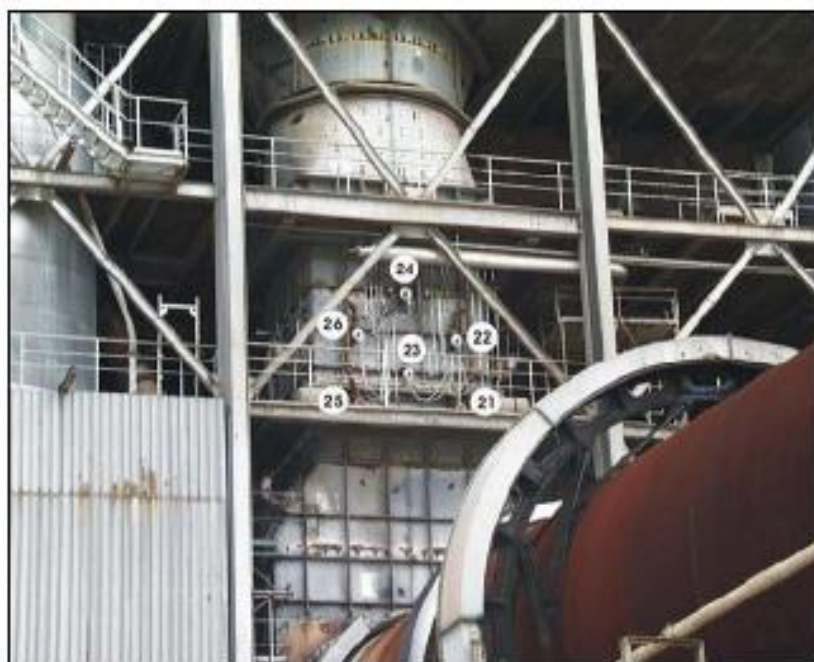
Figure 4.8 : SNCR à haute efficacité et point d'injection d'eau ammoniacale par lance aux positions n° 21 à 26 [76, Allemagne, 2006]
