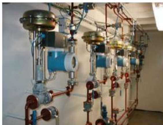
Figure 4.28 : Station de mesure et de dosage à vannes pneumatiques [50, Allemagne, 2006], [51, EuLA, 2006]
