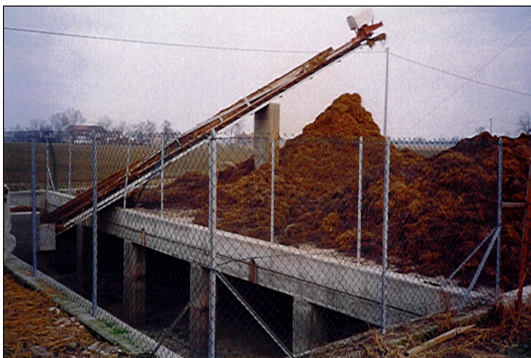
Figure 2.33 : Stockage du fumier à base de litière avec confinement séparé de la partie liquide (Italie)
