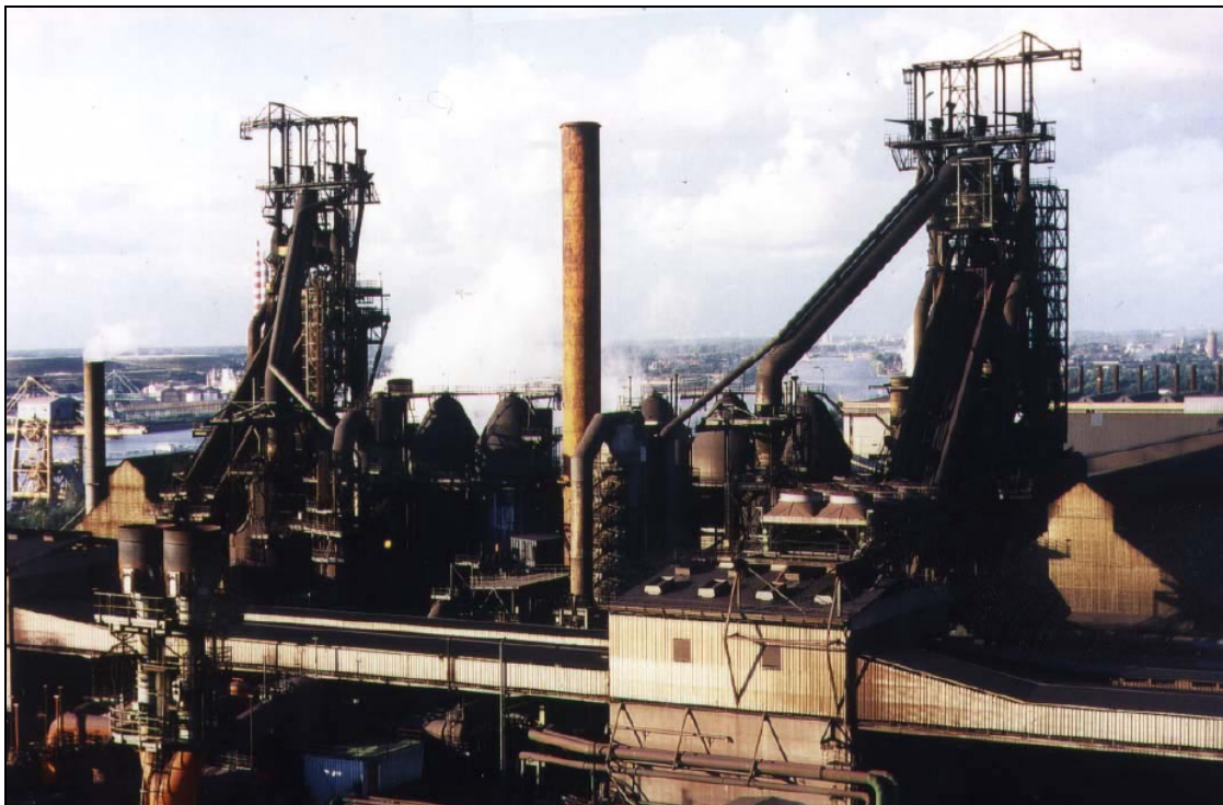
Figure 7.1: Vue d'ensemble de deux hauts fourneaux comprenant chacun trois cowpers et de la cheminée d'acheminement des gaz résiduels provenant des cowpers
