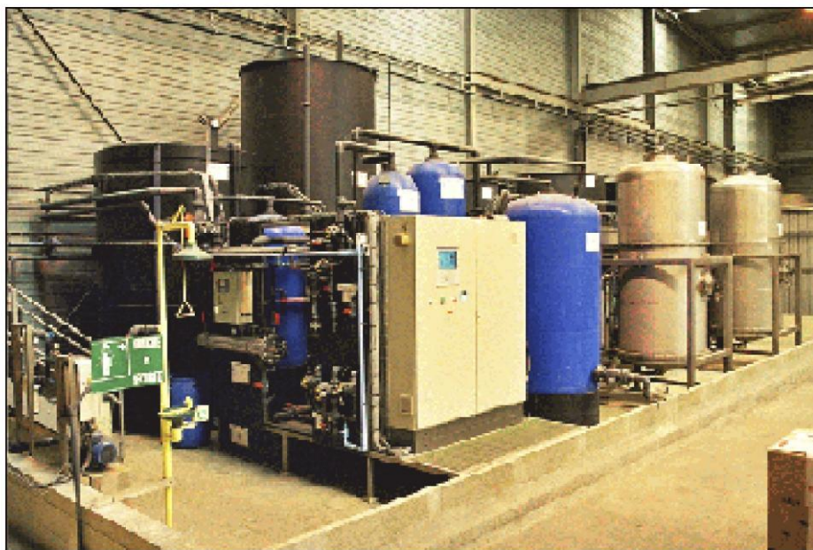
Figure 2.43 : Installation de référence de traitement des eaux résiduaires utilisant l'échange ionique (Productmetal S.A. et Agence de l'eau Seine-Normandie)
